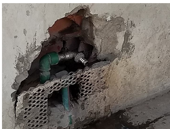
Figura 2. Canilla de acceso público ubicada sobre Osvaldo Cruz próxima a la intersección con la calle Lavarden
